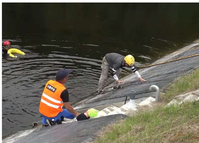
法面にネットの設置
