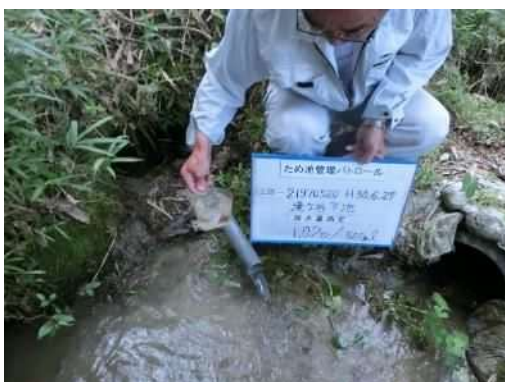
後法 漏水量測定(遠景)
