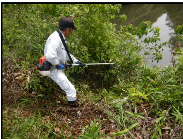
ため池前法での草刈作業の様子
