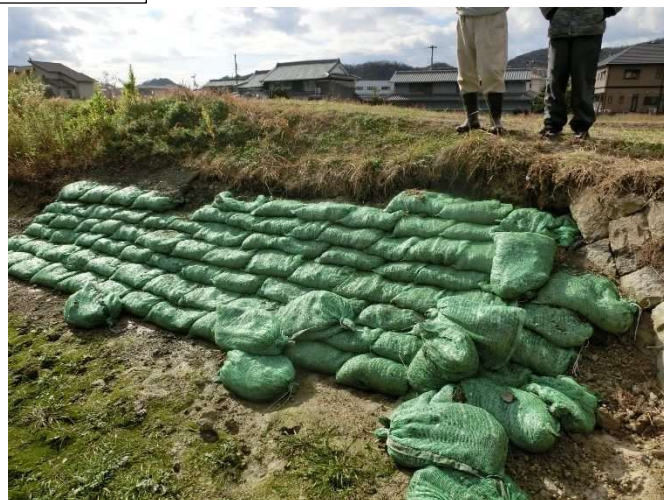
堤体上流法面に土のう設置
