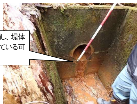
底樋出口(堤体下流)
