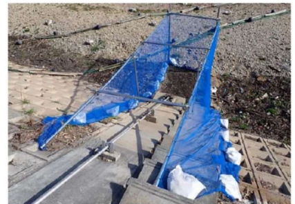
取水施設周りに防風ネットを設置
