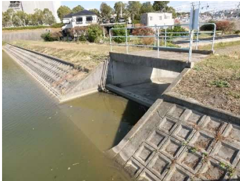
洪水吐(上流側)
