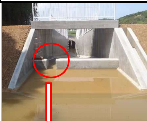
【南あわじ市 洪水吐越流堰の切欠き】
