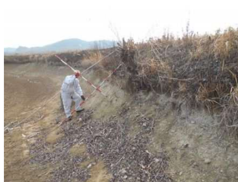
堤体の浸食状況等の点検
