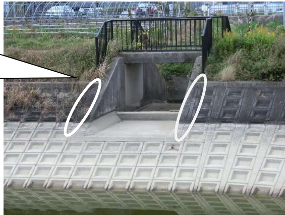
洪水吐(貯水池側より)
