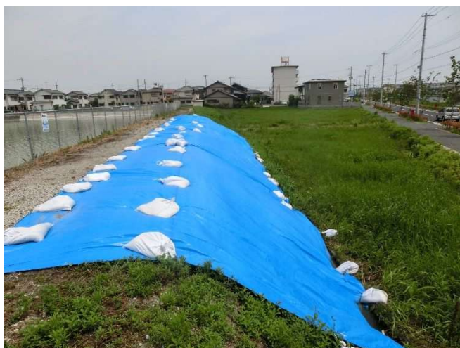
堤体下流法面にブルーシート設置
