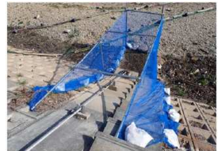
取水施設周りに防風ネットを設置
