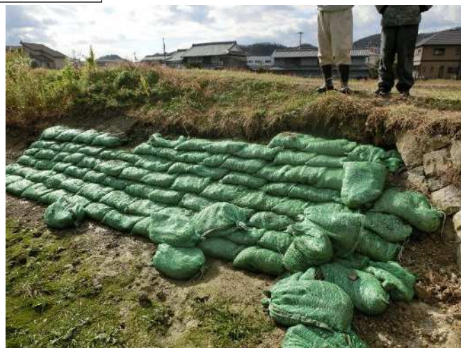
堤体上流法面に土のう設置
