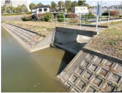
洪水吐(上流側)
