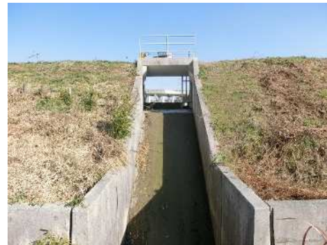
洪水吐(下流側)
