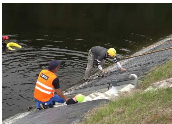
法面にネットの設置
