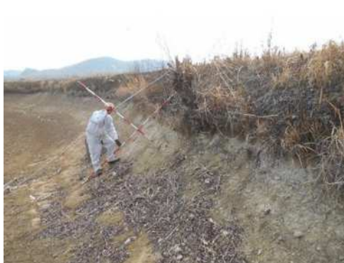
堤体の浸食状況等の点検
