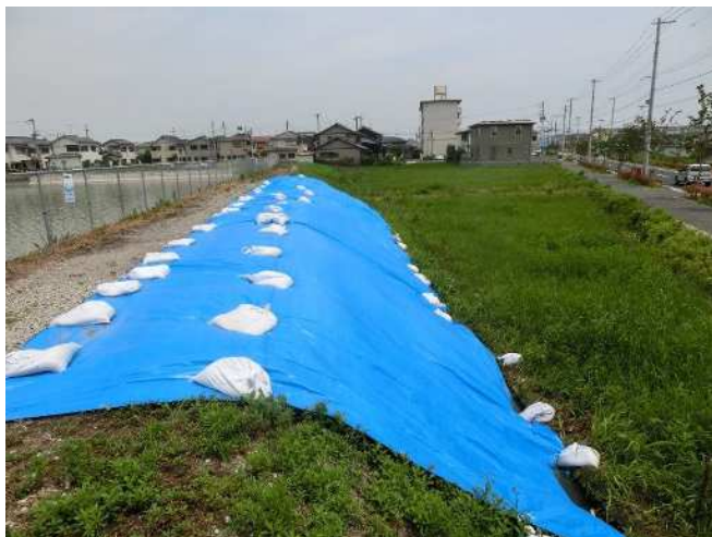
堤体下流法面にブルーシート設置
