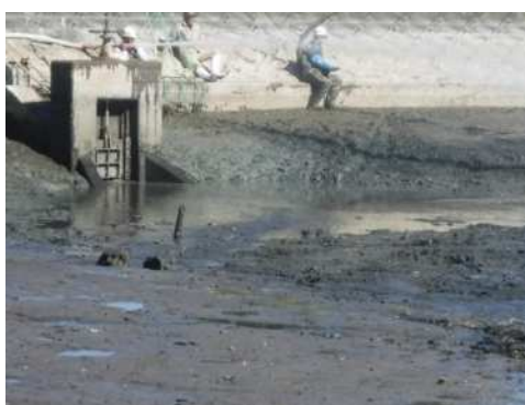
泥土除去後の状況(かいぼり実施後)
