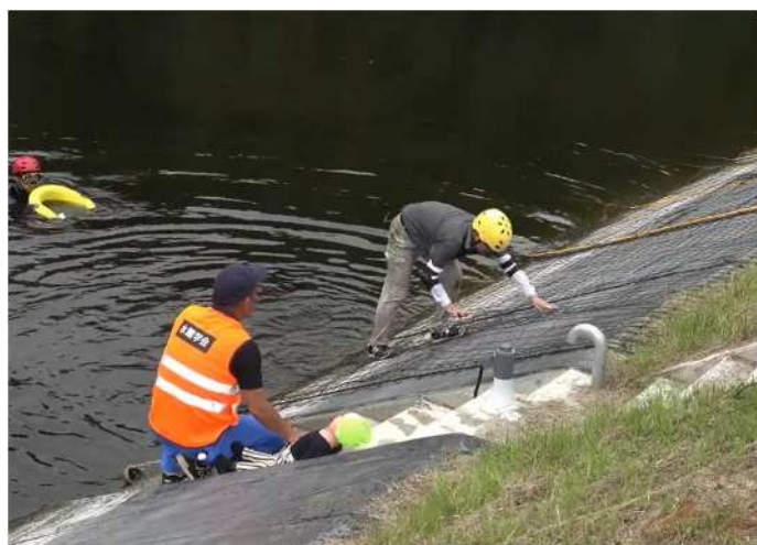
法面にネットの設置
