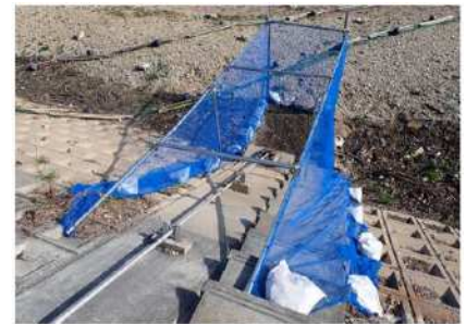
取水施設周りに防風ネットを設置
