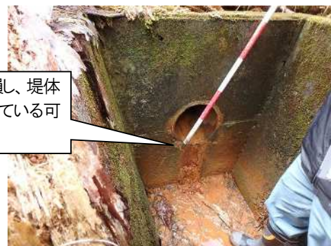
底樋出口(堤体下流)
