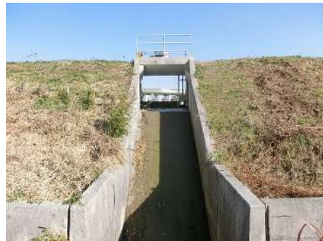
洪水吐(下流側)
