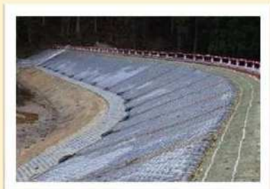
脱出を補助する救助ネット
