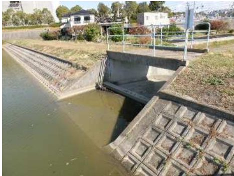
洪水吐(上流側)
