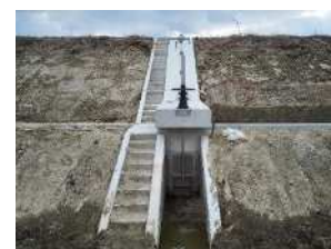
取水施設(底樋)
