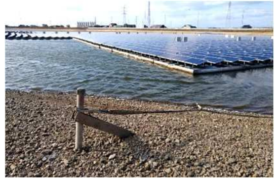
打ち込みアンカーによる係留
