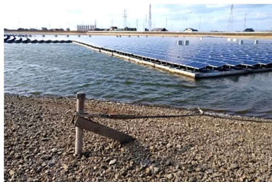
打ち込みアンカーによる係留
