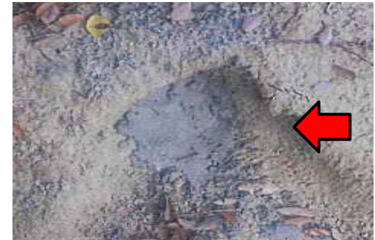
漏水口をモルタルで充填
