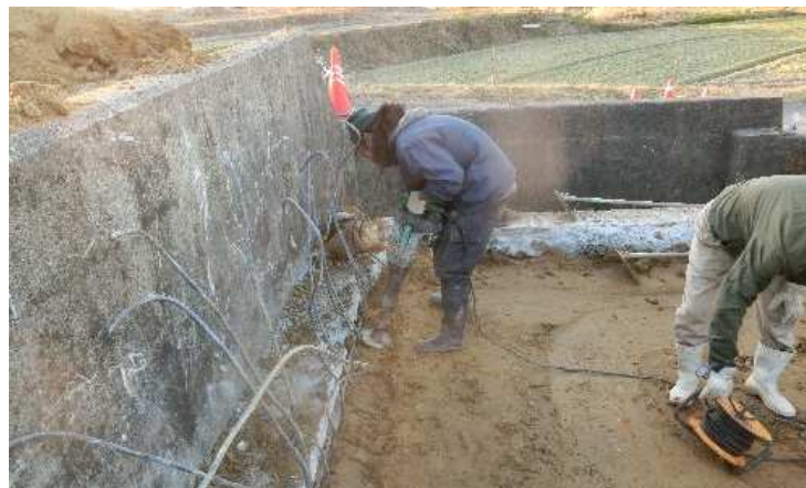
ハンマードリルの先を円盤に替えて、振動を利用して転圧
