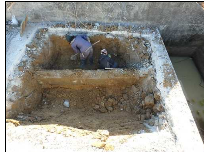
漏水箇所まで掘削して床均しを実施します。
