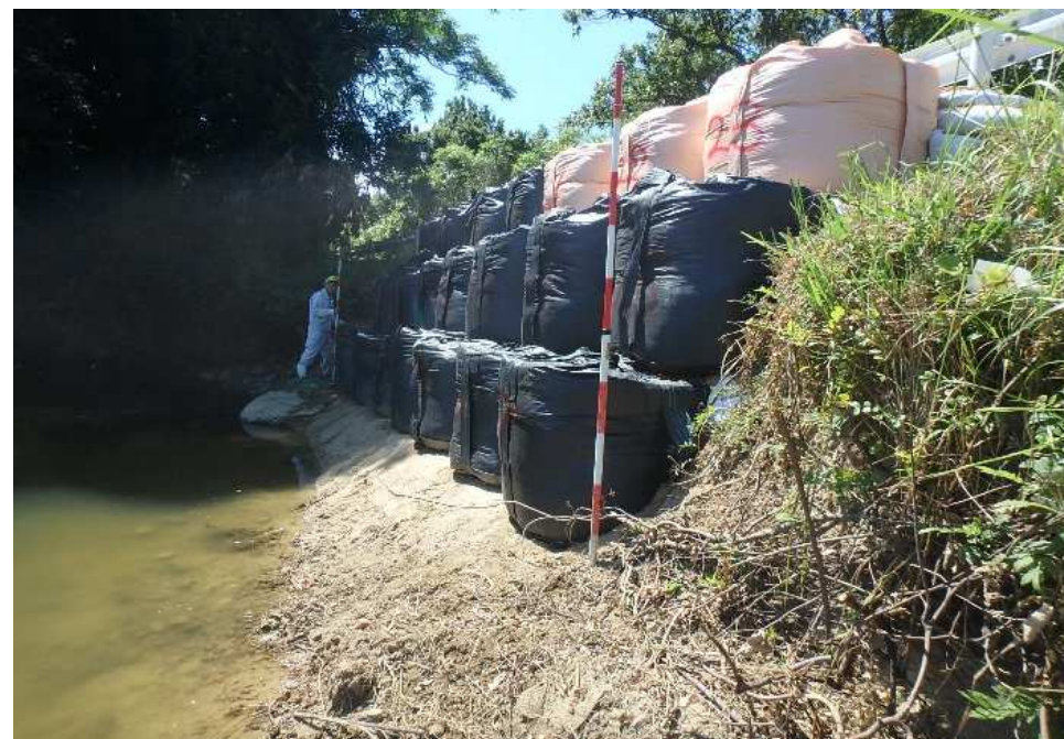
基礎地盤に大型土嚢を積み、裏を転圧
