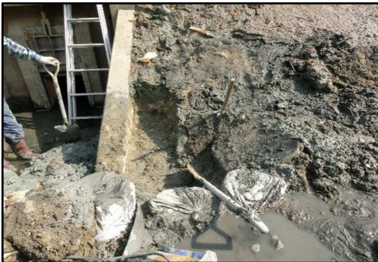
②ため池築堤用土で締め
