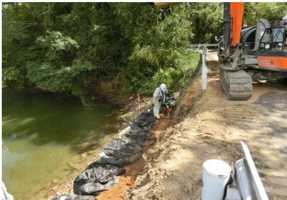
基礎地盤に大型土嚢を積み、裏を転圧
