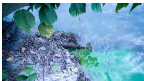
下流側洪水吐壁面から漏水
