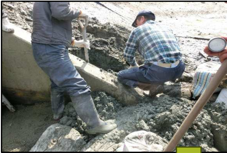
②ため池築堤用土で締め
