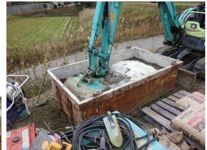
バックホーのバケットで混合し、隅は人力で均一に混合する。
