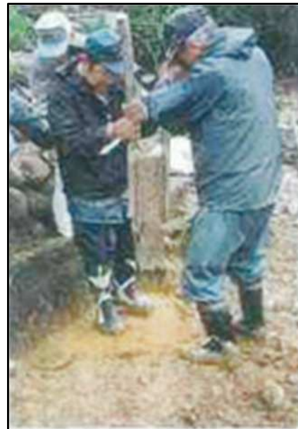
②タコ等による締め固め。
