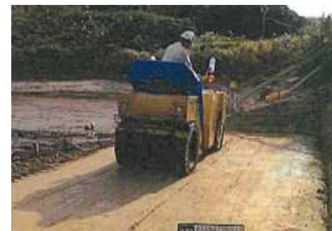
振動ローラによる転圧 (巻き出し厚 30cm、転圧5回)
