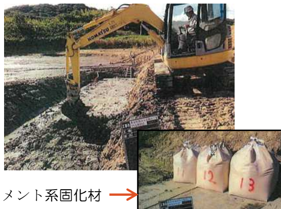
バックホーによる混合
