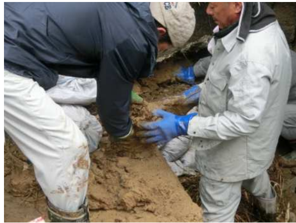
割れ目に粘土挿入と突き固め
