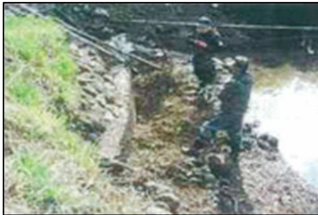
①穴の確認と埋戻土のなじみを良くするため掘削する。
