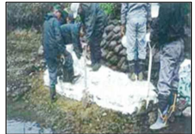
③締め固めた部分表面を土嚢で覆う。
