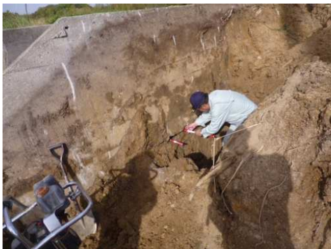
洪水吐の側壁裏を掘削して、漏水箇所を確認し、漏水口の確認を実施します。
