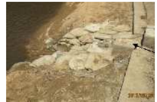
取水施設との隙間に土嚢を詰め、水の浸食を防ぐ
