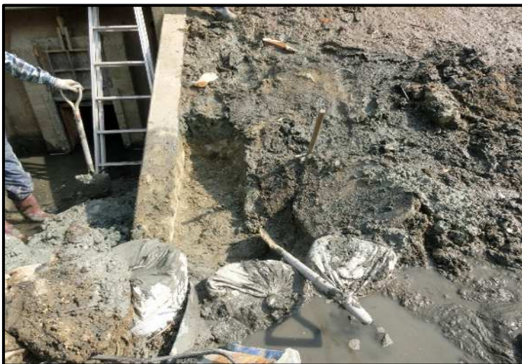
②ため池築堤用土で締め
