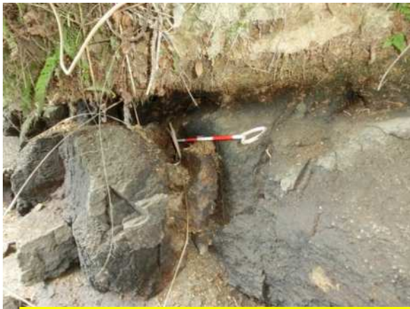
地山接触部が風化した割れ目の多い花崗岩から漏水
