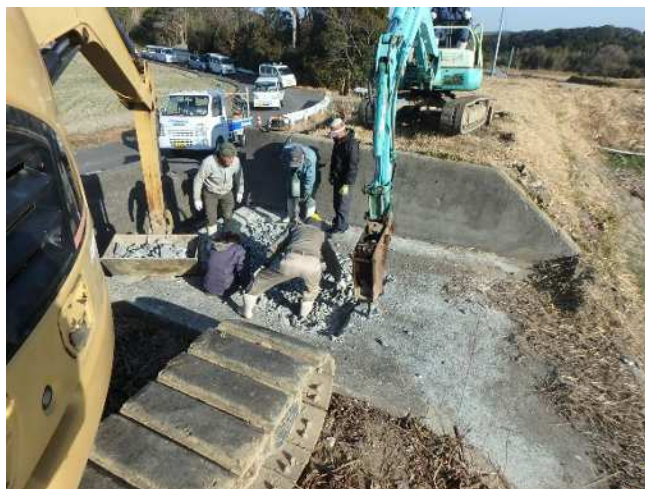
底版下からの漏水のため、底版コンクリートを機械で破碎します。
