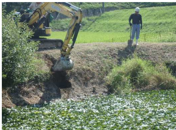
バックホーによる掘削
