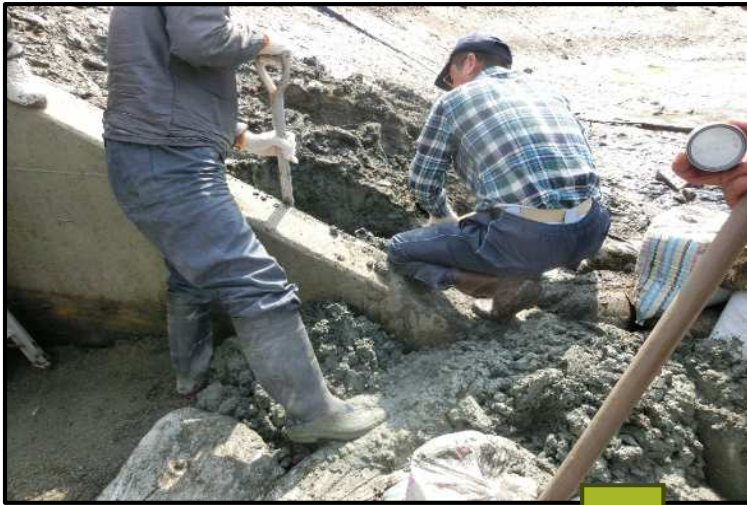
②ため池築堤用土で締め
