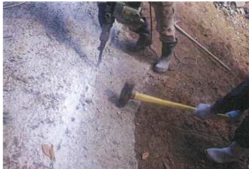
張コンクリートの取り壊し
