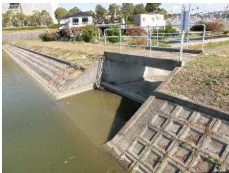
洪水吐(上流側)
