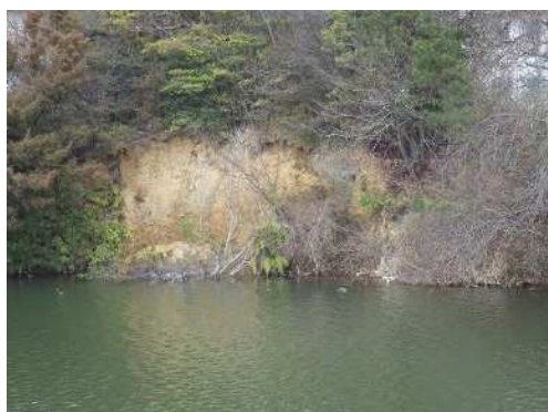
ため池周囲 土砂崩壊
