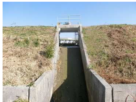
洪水吐(下流側)
