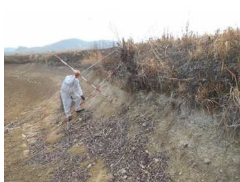
堤体の浸食状況等の点検
