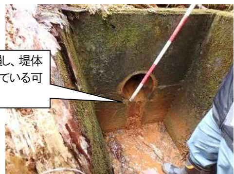
底樋出口(堤体下流)
