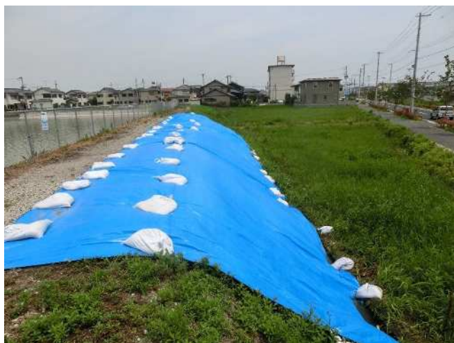
堤体下流法面にブルーシート設置
