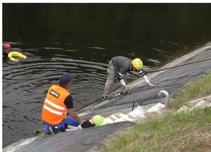
法面にネットの設置
