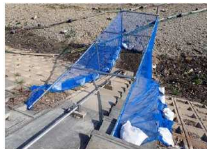
取水施設周りに防風ネットを設置
