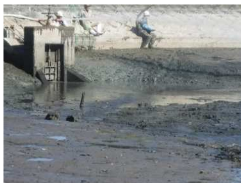
泥土除去後の状況(かいぼり実施後)
