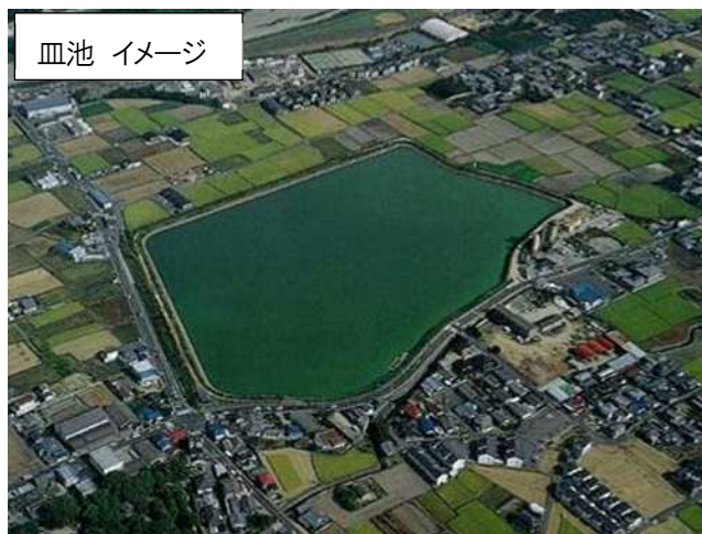
皿池 イメージ 平地で窪地の周囲に堤防を築いて造られたため池
