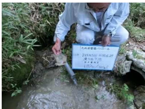
後法 漏水量測定(遠景)
