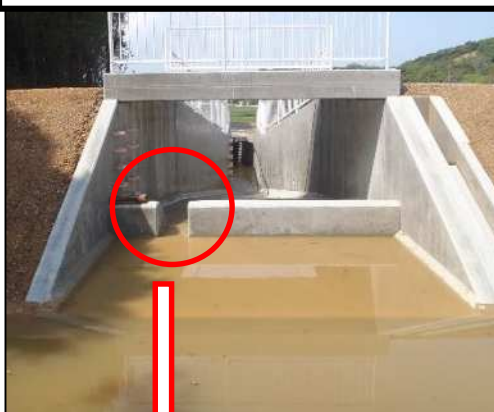
【南あわじ市 洪水吐越流堰の切欠き】
