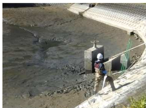
泥土堆積状況(かいぼり実施前)
