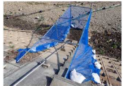
取水施設周りに防風ネットを設置
