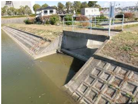
洪水吐(上流側)
