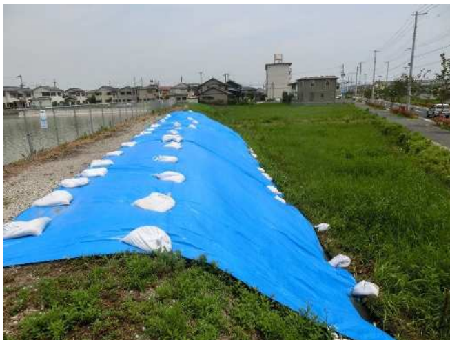
堤体下流法面にブルーシート設置
