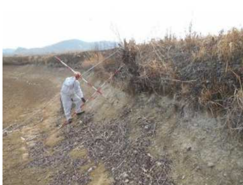
堤体の浸食状況等の点検
