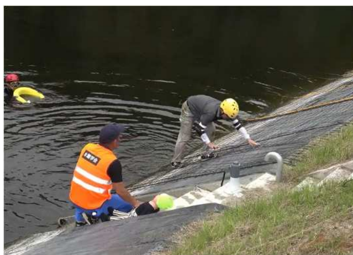
法面にネットの設置
