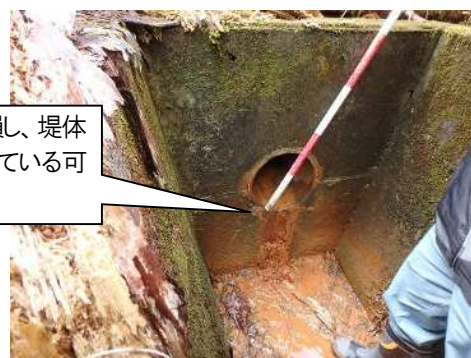
底樋出口(堤体下流)
