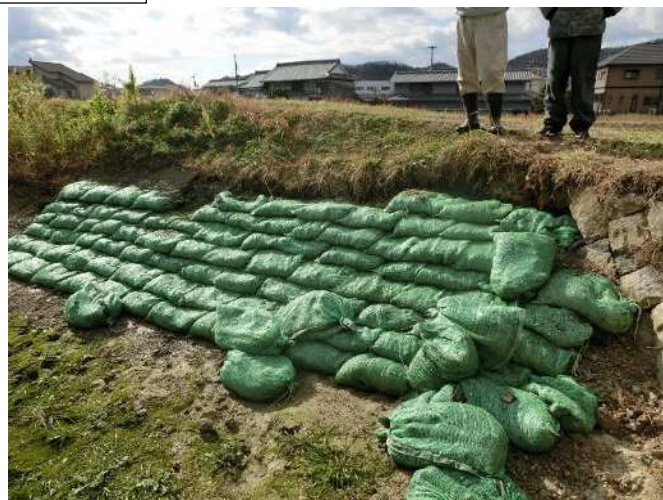
堤体上流法面に土のう設置
