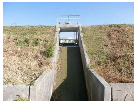
洪水吐(下流側)
