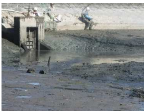
泥土除去後の状況(かいぼり実施後)
