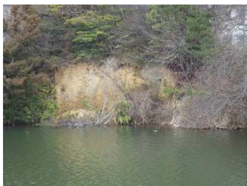
ため池周囲 土砂崩壊
