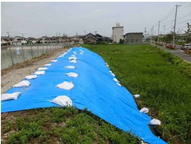
堤体下流法面にブルーシート設置
