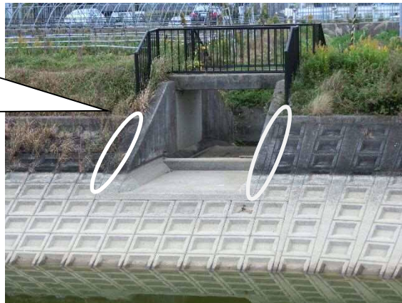
洪水吐(貯水池側より)
