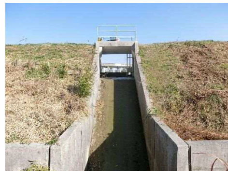
洪水吐(下流側)
