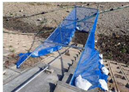
取水施設周りに防風ネットを設置
