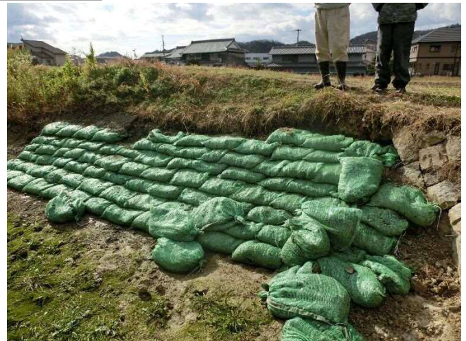
堤体上流法面に土のう設置
