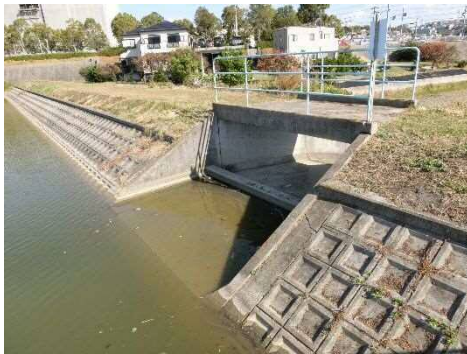
洪水吐(上流側)
