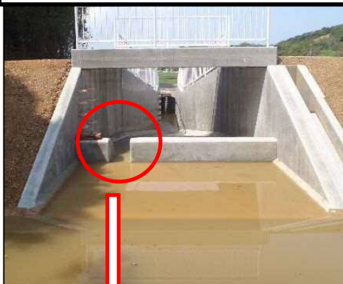
【南あわじ市 洪水吐越流堰の切欠き】
