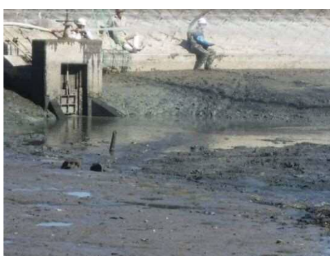
泥土除去後の状況(かいぼり実施後)
