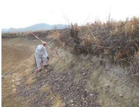
堤体の浸食状況等の点検
