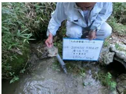
後法 漏水量測定(遠景)
