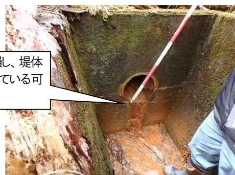
底樋出口(堤体下流)
