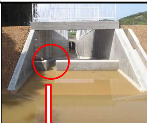
【南あわじ市 洪水吐越流堰の切欠き】
