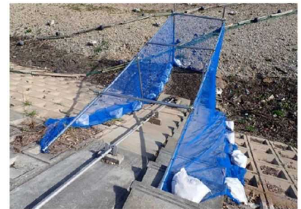
取水施設周りに防風ネットを設置
