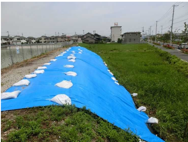
堤体下流法面にブルーシート設置
