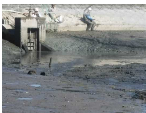
泥土除去後の状況(かいぼり実施後)
