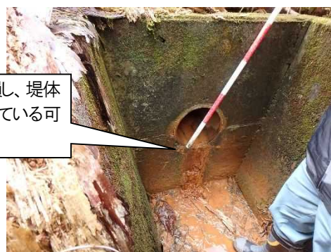
底樋出口(堤体下流)
