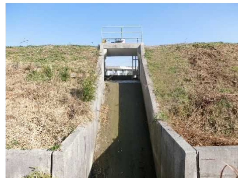
洪水吐(下流側)
