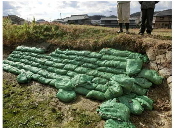
堤体上流法面に土のう設置
