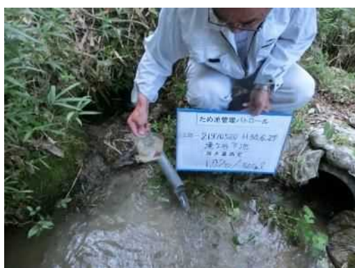
後法 漏水量測定(遠景)
