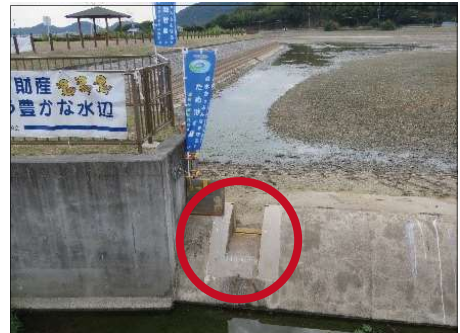
洪水吐切欠き（高砂市 惣毛池）
