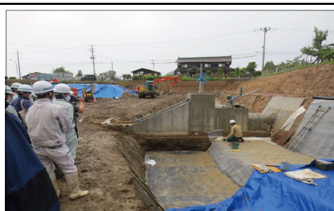
ベントナイトシート工法現場見学
