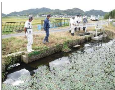
サポートセンターによる現地確認
