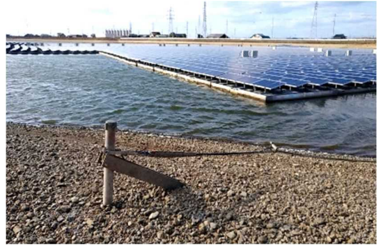
打ち込みアンカーによる係留
