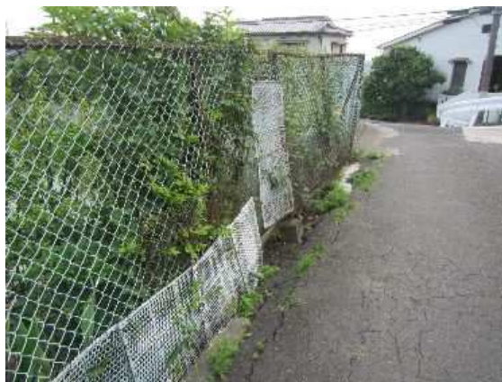
金網による応急措置の状況
