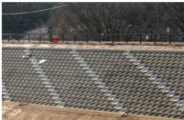
防災タイプを階段状に設置
