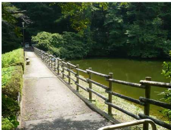
転落防止柵の設置状況
