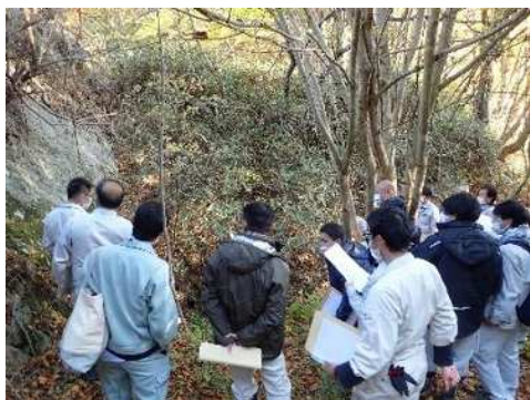
ため池の漏水の有無の確認
