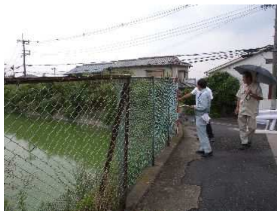
ため池の点検状況
