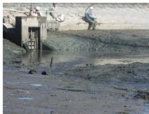
泥土除去後の状況(かいぼり実施後)
