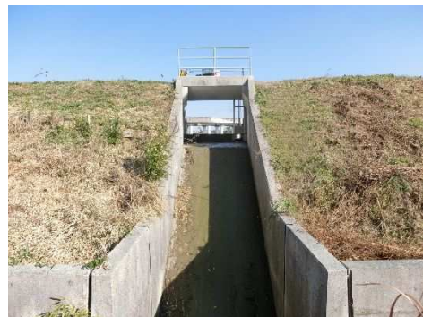
洪水吐(下流側)
