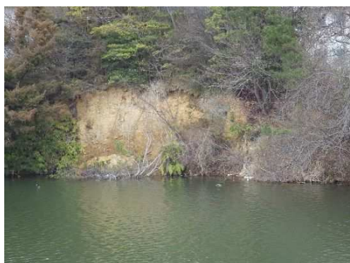
ため池周囲 土砂崩壊
