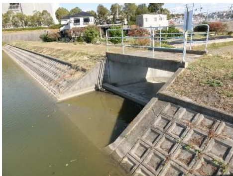
洪水吐(上流側)
