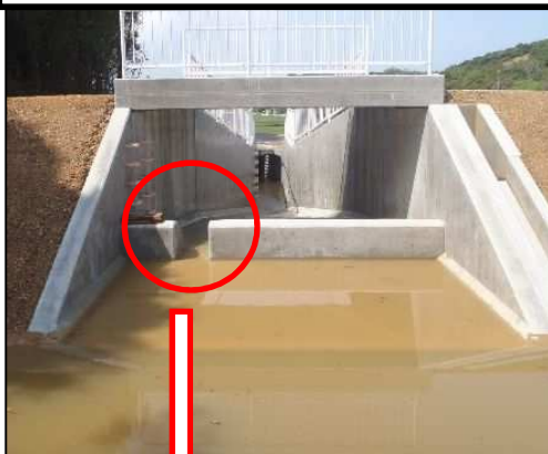
【南あわじ市 洪水吐越流堰の切欠き】
