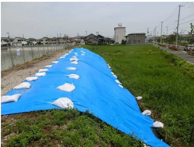
堤体下流法面にブルーシート設置
