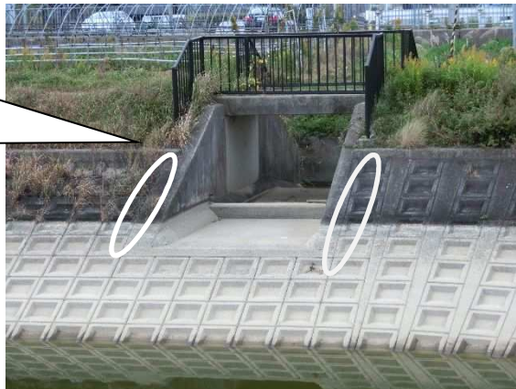
洪水吐(貯水池側より)
