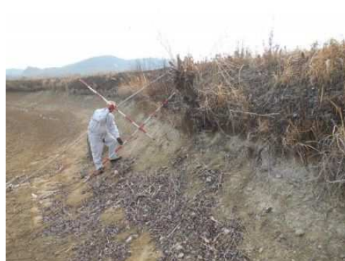
堤体の浸食状況等の点検
