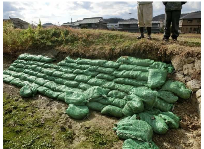
堤体上流法面に土のう設置
