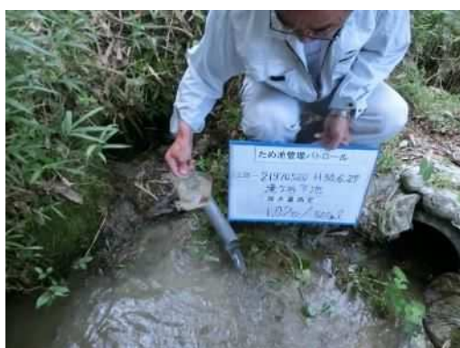
後法 漏水量測定(遠景)
