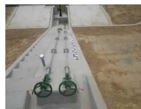
取水施設(斜樋)
