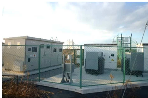
変電設備における侵入防止柵
