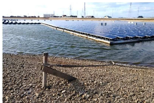
打ち込みアンカーによる係留
