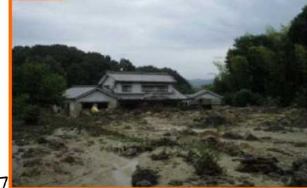
ため池上部のグラウンドの崩壊による土砂流入により、ため池が決壊。18
