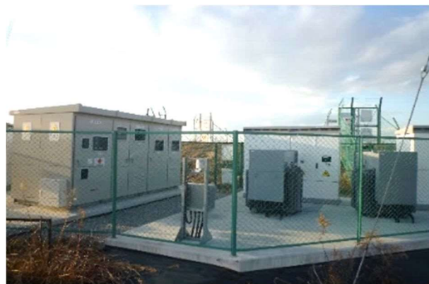
変電設備における侵入防止柵
