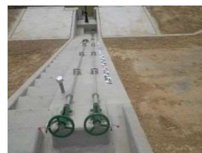
取水施設(斜樋)
