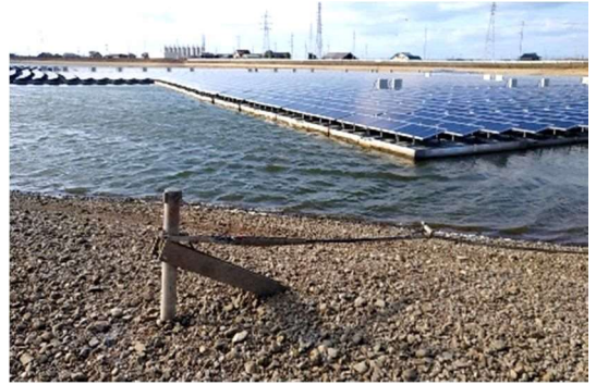
打ち込みアンカーによる係留
