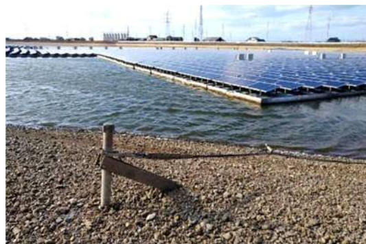
打ち込みアンカーによる係留
