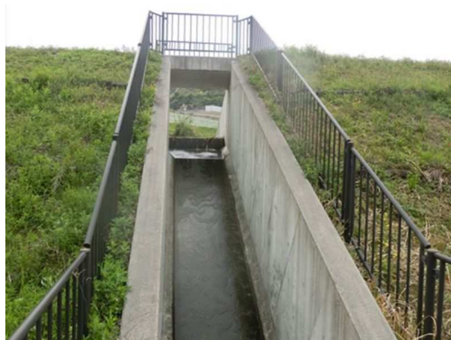
洪水吐(下流側)
