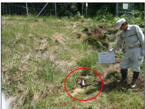
後法 漏水(遠景)
