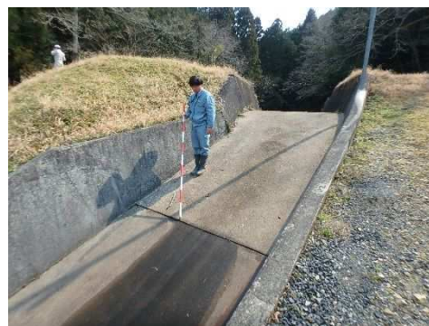
放水路部 漏水
