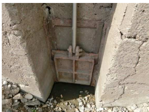
取水施設ゲート部 腐食及びクラック
