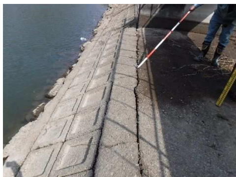
流入部 ひび割れ
