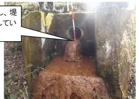
底樋出口(堤体下流)
