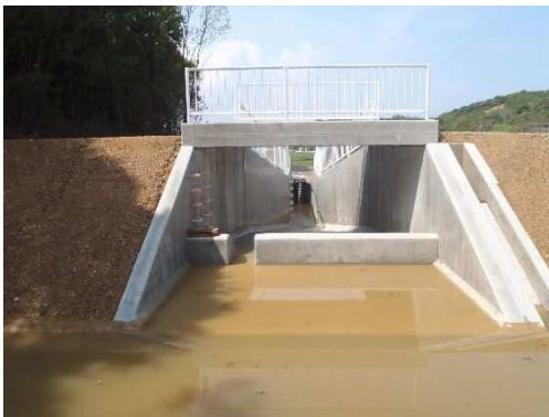
洪水吐 越流堰の切欠き
