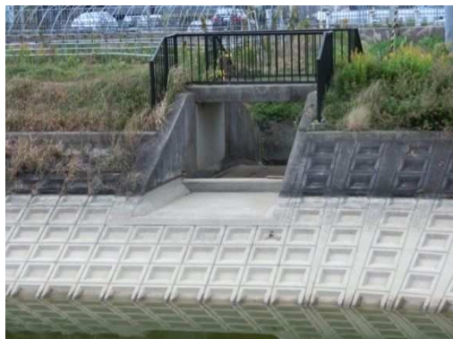
洪水吐(上流側)
