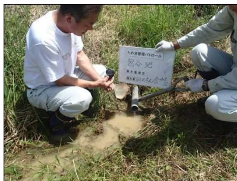
後法 漏水(近景)
