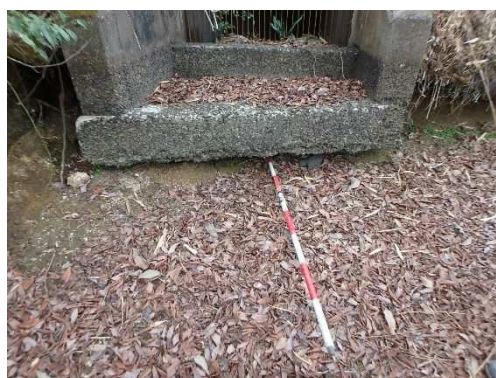
洪水吐 構造物周りの浸食
