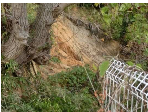
ため池周囲 土砂崩壊
