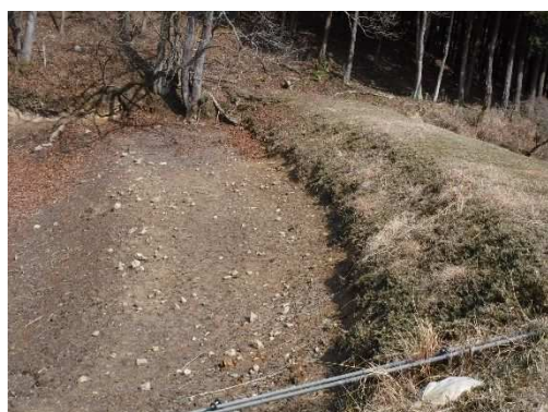
堤体の浸食状況
