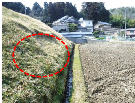
後法 はらみだし及び陥没
