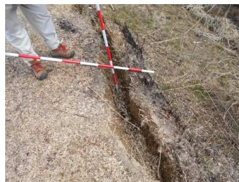
堤頂 ひび割れ
