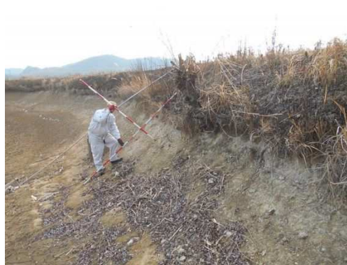
堤体の浸食状況
