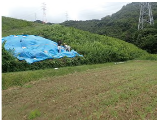
猪によるため池堤体の被害
