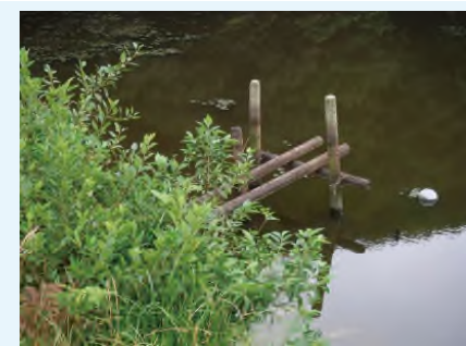
老朽化で取水、放流ができなくなった木樋
