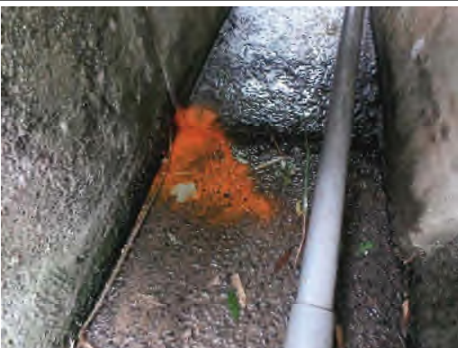
色粉を投入し、漏水箇所を確認
